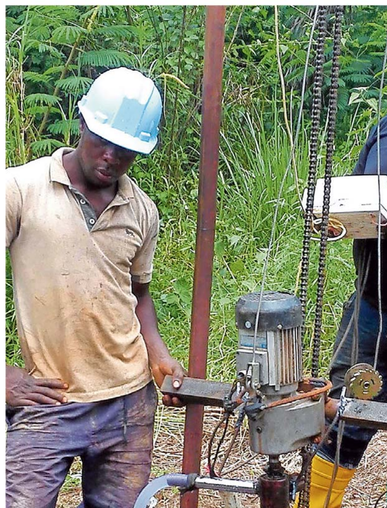
Zwei Arbeiter beim Bau des Brunnens.
